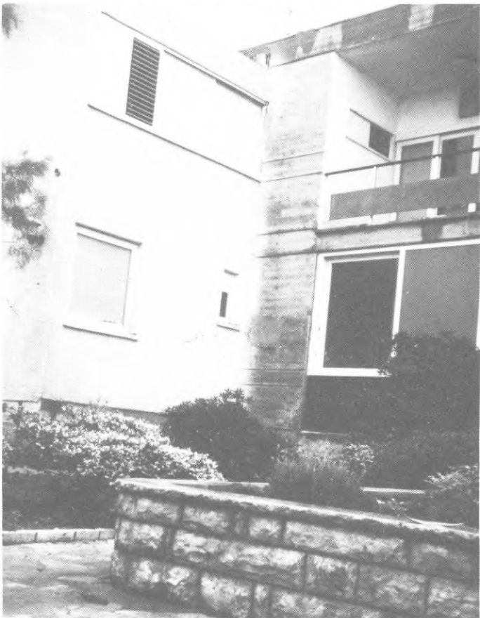
Abb. 2: Rückseite mit Garten, an der Rückseite entlanglaufende Terrasse, abgeteilt jeweils für jedes Appartement (s. Abb. 1. Etage)
