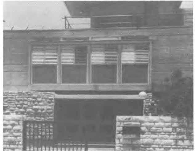
In der Henrietta-Szold 3 -Str. 24: Das renovierte Haus**. Schon der Eingang des Hauses zeigt, dass das Heim Behinderten gerecht wird. Dies ist für das ganze Haus kennzeichnend.
